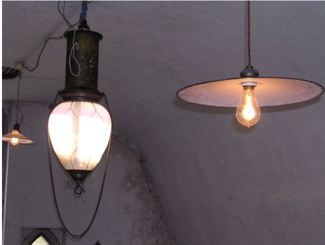
Lampe à arc et ampoules à filament de carbone (qui ont plus de 100 ans) en fonctionnement.
